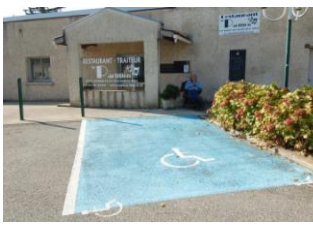
Place de parking PMR proche de l'entrée
