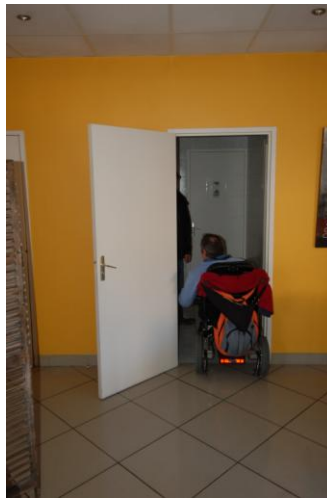
L'entrée des toilettes se fait par une petite porte où il faut manœuvrer avec prudence
