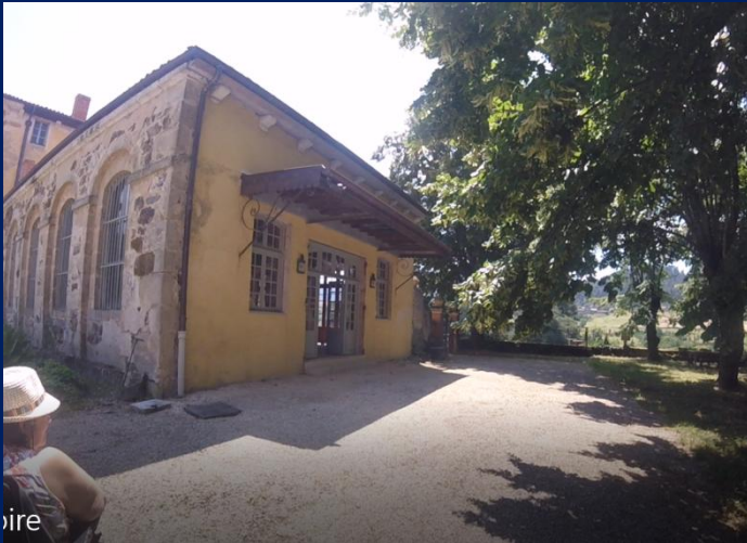
Aile ouest du château.
