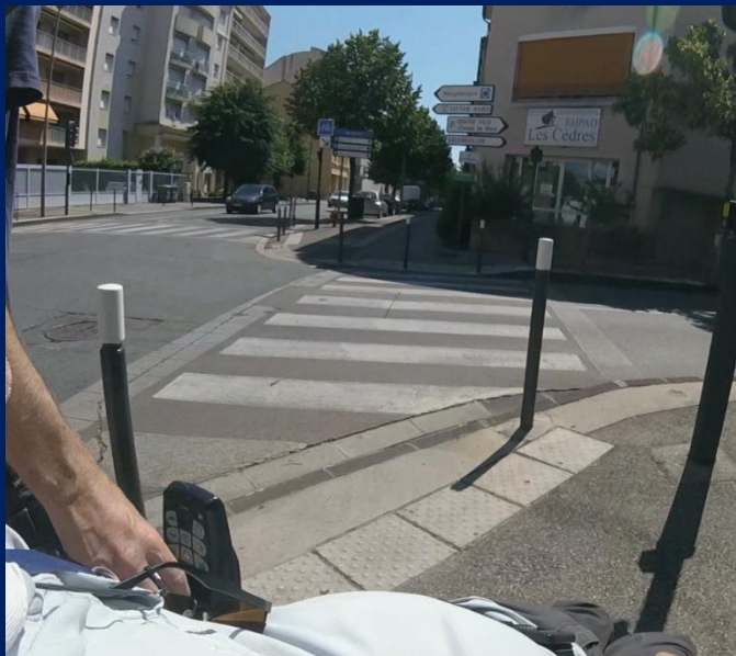
Passage piéton rue de l'Espérance, traversée correct. Pas de bande de guidage. Feu sonore pas audible.
