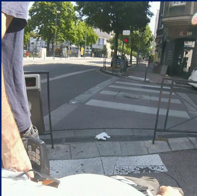
Passage piéton rue François Rabelais, traversée correcte. Pas de bande de guidage.
