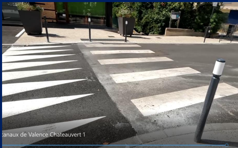
Traversée piétonne rue Chateaufvert, très bien.
